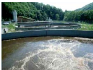
ภาพที่ 20 ตัวอย่างระบบเติมอากาศแบบเวนจูรีชนิดติดตั้งใต้น้ำ
