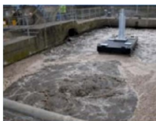
ภาพที่ 22 ตัวอย่างระบบเติมอากาศแบบเวนจูรีชนิดติดตั้งกับทุ่นลอย
