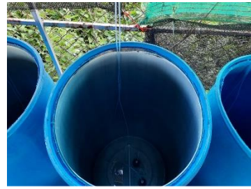
ภาพที่ 2 ติดตั้งระบบให้อากาศ
